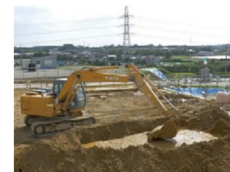
淤泥转移工程
