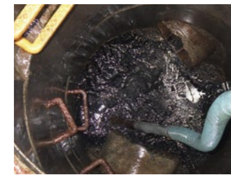
污水井淤泥处理
