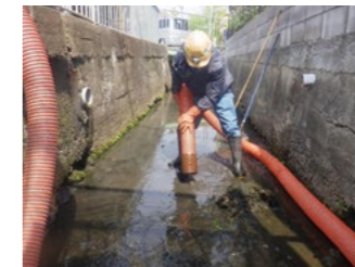
灌溉沟渠·小孔施工
