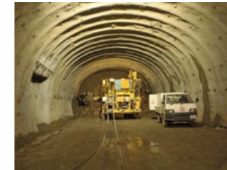
隧道掘进工程
